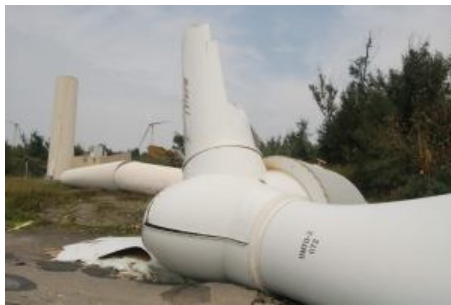
圖1-1風力發電機組被薔蜜颱風吹倒
